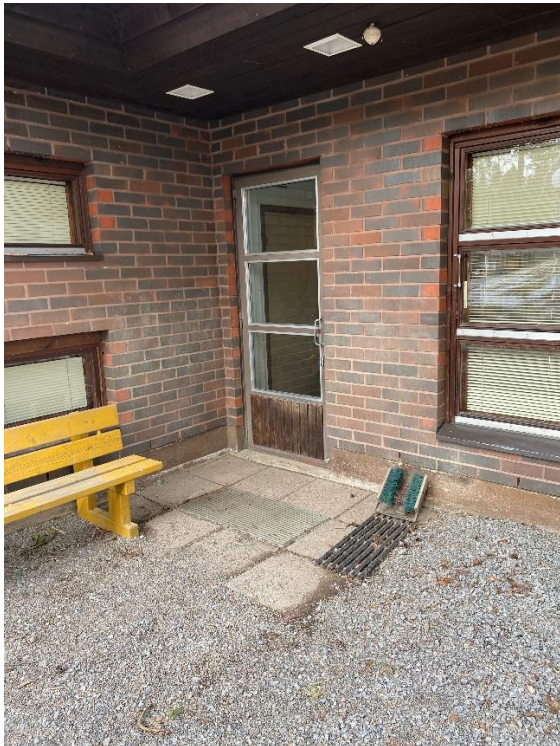
Kuva RAK 10 Oven puuosien kunnostus
