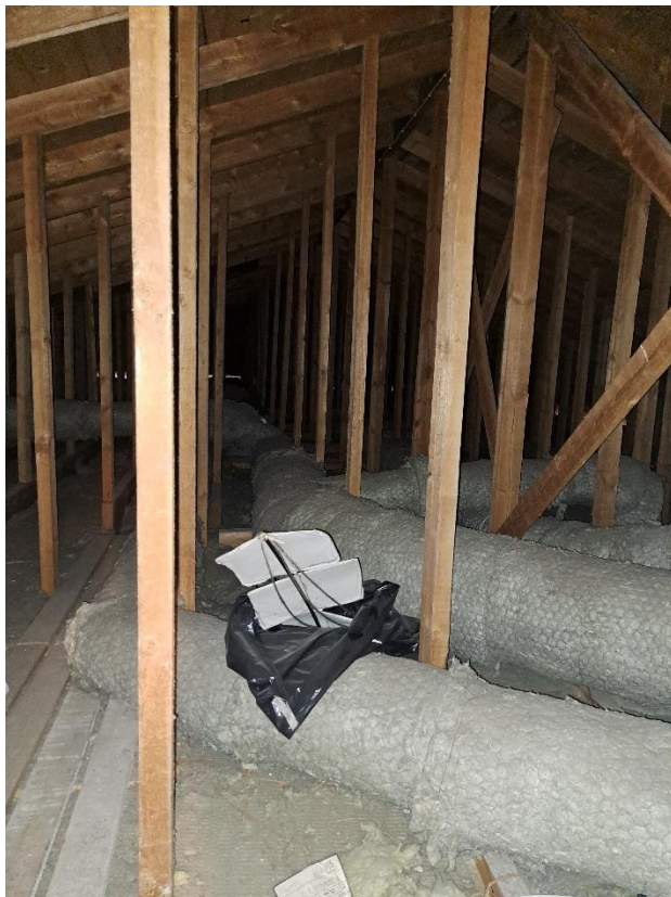
Kuva LVI9 Ilmanvaihtokanavien eristyksiä ullakkotilassa
