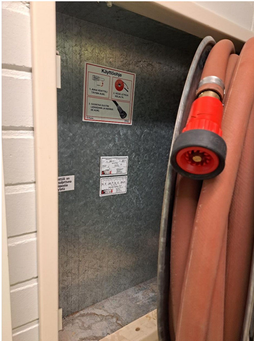
Kuva LVI11 Pikapaloposti jonka tarkastus on vanhentunu
