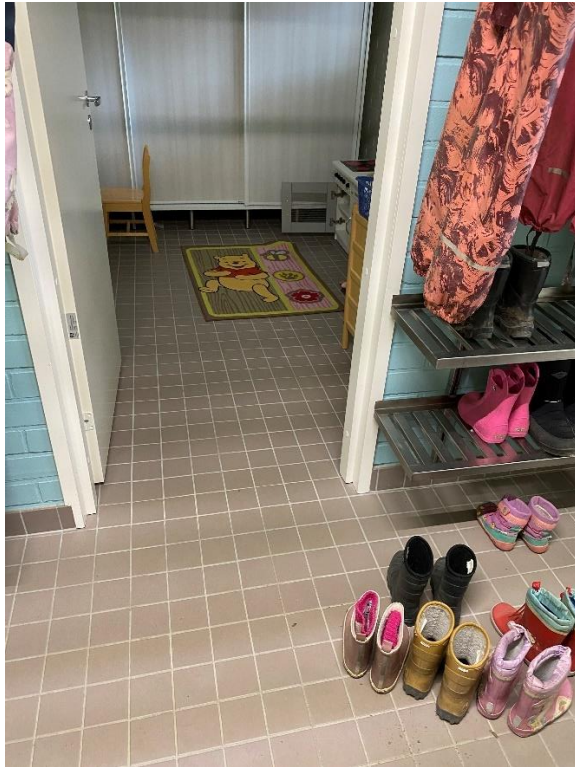
Kuva RAK14 Laattalattiat siistit ja ehjät
