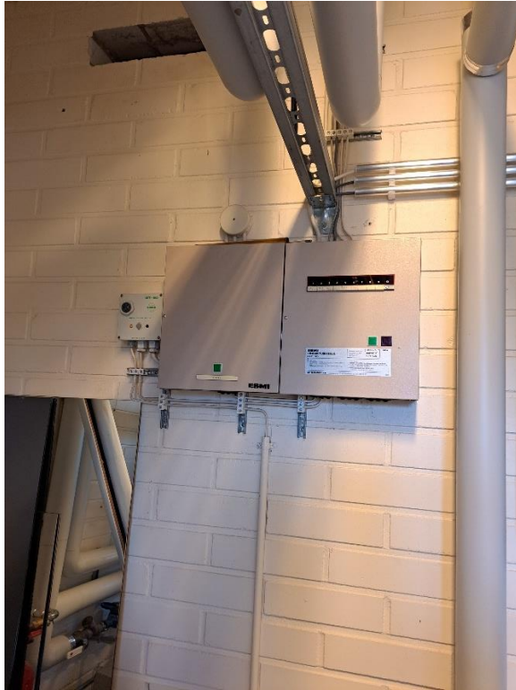
Kuva LVI3 Alkuperäinen LVI-hälytyskeskus, vasemmalla rasvanerotuskaivon täyttymishälytin
