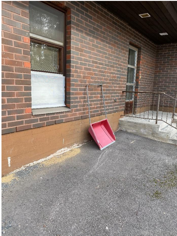
Kuva RAK3 Sokkelissa pieniä maalikorjauksia.
