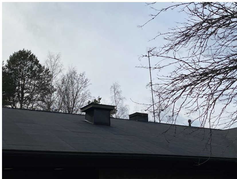
Kuva RAK20 Vesikate silmämääräisesti tarkasteltuna kunnossa.
