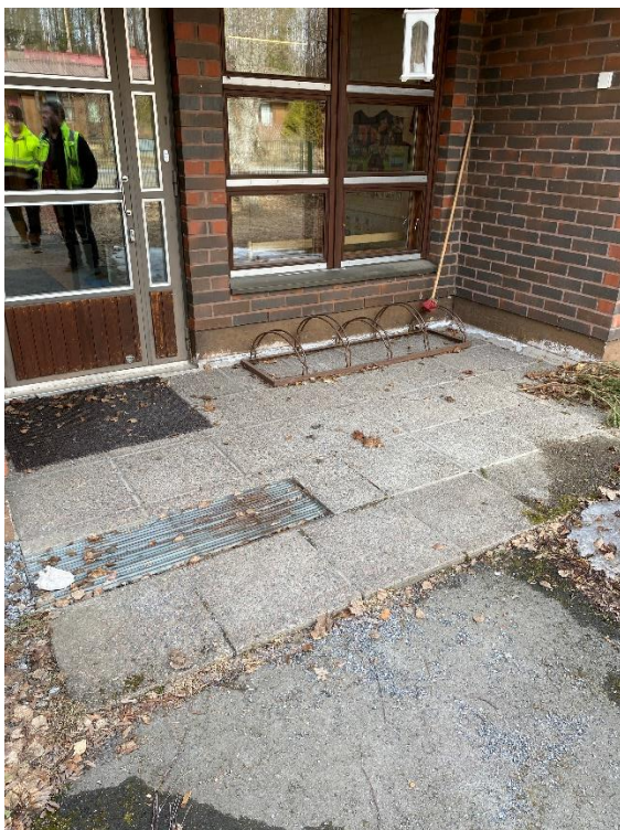
Kuva RAK12 Pääsisäänkäynti
